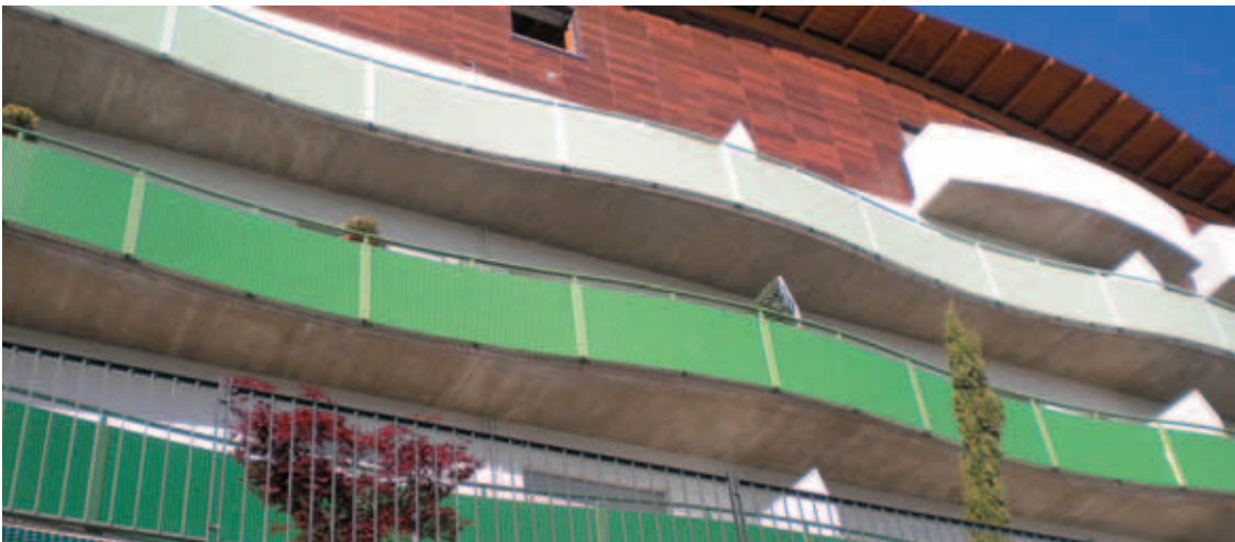
Projekt: Ing. Giuditta Pezzotta - Masche: Idea - DL 76 x DC 31 (24) - av 11 x sp 1,5 mm Verzinkter Stahl, lackiert
